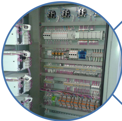
Gabinete control y protecciones
