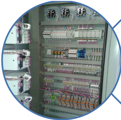
Gabinete control y protecciones
